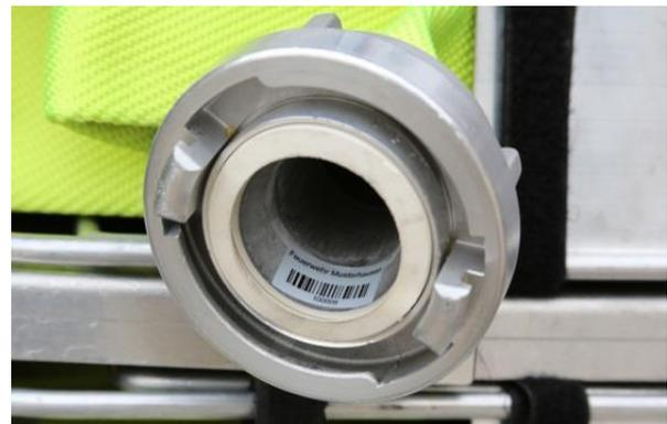
Das Etikett sollte die Größe „klein“ (30x15 mm) haben und jeweils **in** der Kupplung verklebt werden. Das Programm MP-FEUER kann in der Schlauchverwaltung deshalb 2 **unterschiedliche** Barcodes pro Schlauch verwalten. D.h. egal welche der beiden Kupplungen Sie scannen, der Schlauch wird immer gefunden. Sollte einer der beiden Barcodes defekt sein, muss der andere nicht ebenfalls ersetzt werden!
